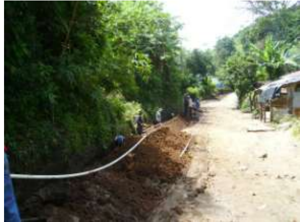
Instalación de tubería hacia la escuela.
